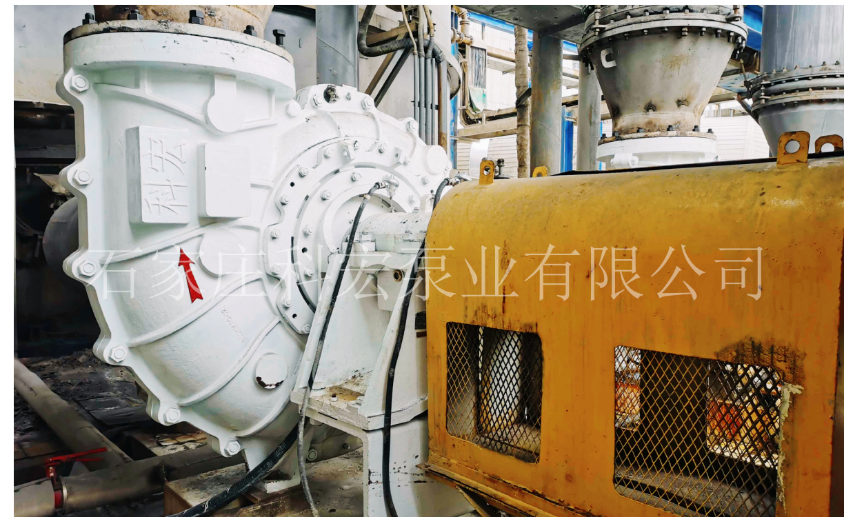
📍 C800KT陶瓷泵应用于大唐河北某电厂2X660MW燃煤热电联产等容量替代项目
