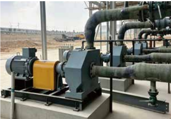
宁夏某化工项目
